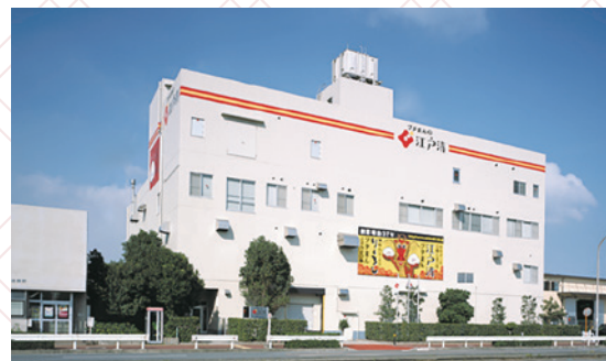
▲金沢区幸浦「横浜本社工場（本社事務所）」
