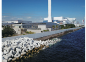
※写真は台風15号の影響に伴う災害対策工事の様子です。
